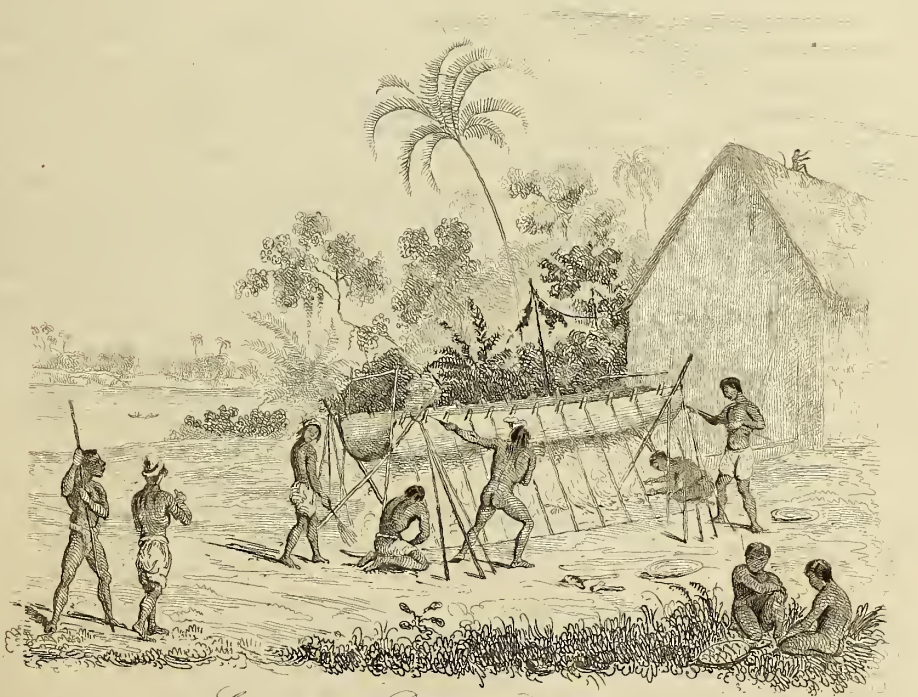
4. Construction des Proquis, à Poste des Mercurios.
